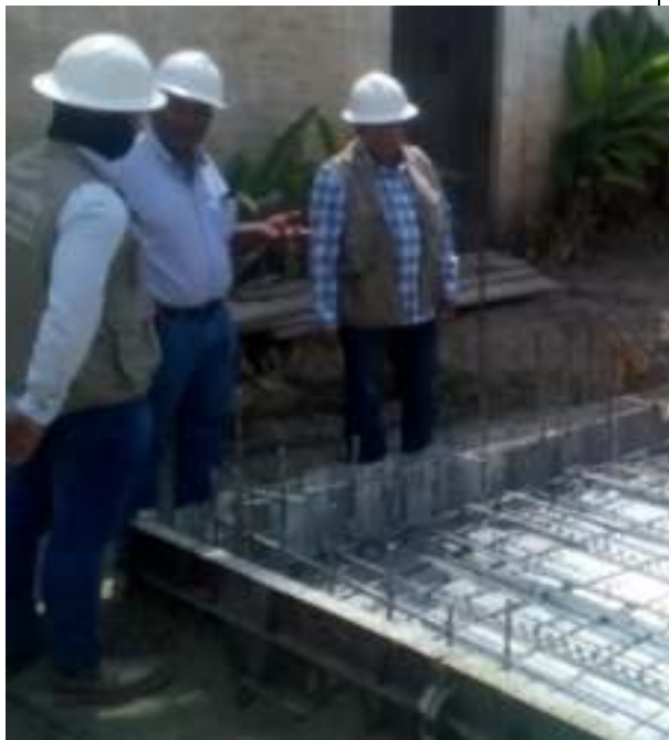
CONSTRUCCION LOSA DE CUBIERTA DE LA EBAREBAR
