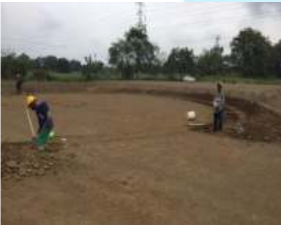
Excavación manual para la fundición del refuerzo losa del tanque de almacenamiento
