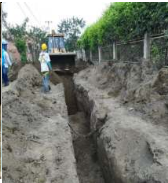
PROCESO DE EXCAVACION DONDE SE OBSERVA LO ANGOSTO DE LA VIA.
