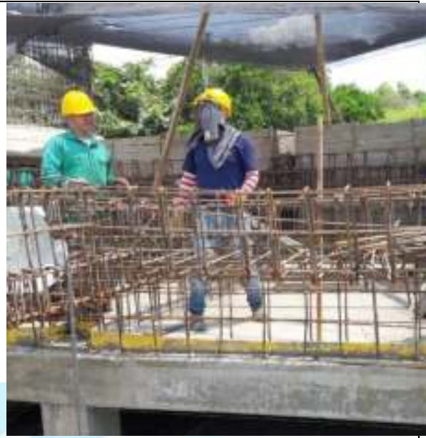
PROCESO DE ARMADO ACEROS DE REFUERZO PLANTA DE TRATAMIENTO.
