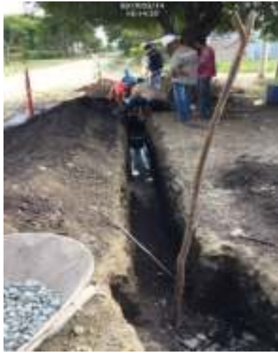
Excavación para instalación de tubería
