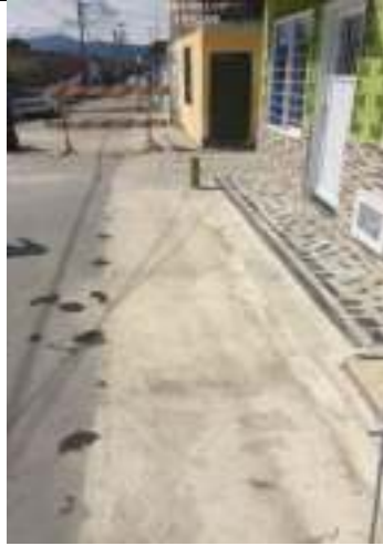
Reposición de andenes
