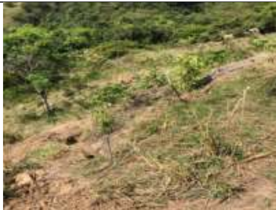
Recorrido trazado nueva ruta PTAP al Tanque el Chuzo - Excavación e Instalación Tubería
