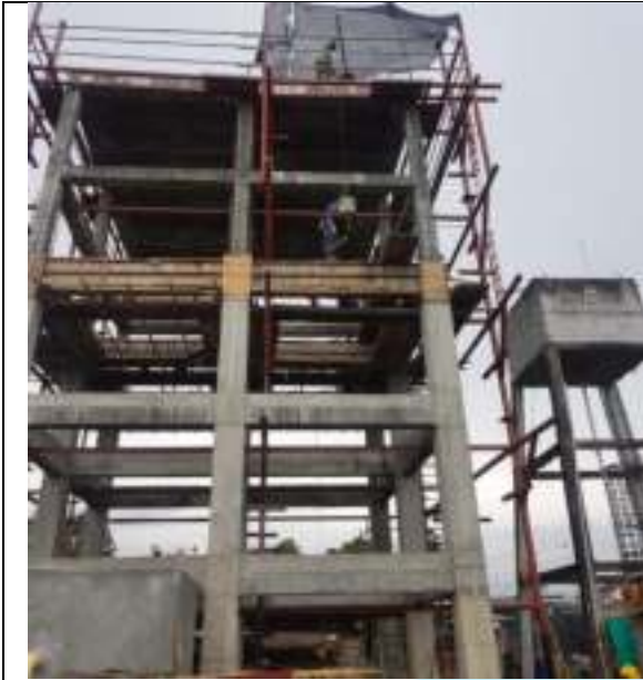
PROCESO DE VACIADO DEL CONCRETO PARA EL REFORZAMIENTO DE LA ESTRUCTURA DEL TANQUE ELEVADO.
