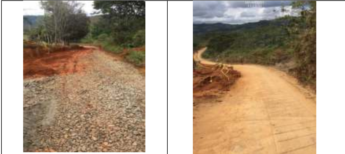
Adecuación de la vías después de la intervención
