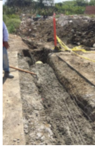
Recubrimiento tubería, manejo de aguas lluvias
