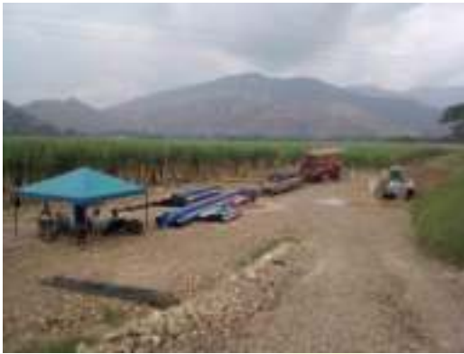
Instalación de la máquina perforadora
