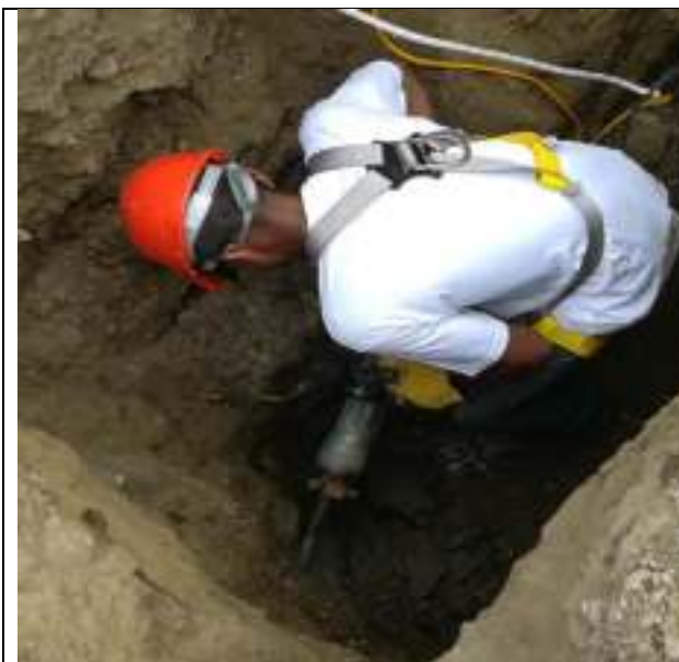
ROTURA DE CAMARA DE ALCANTARILLADO PARA REALIZAR EMPALME CON LAS NUEVAS REDES INSTALADAS.
