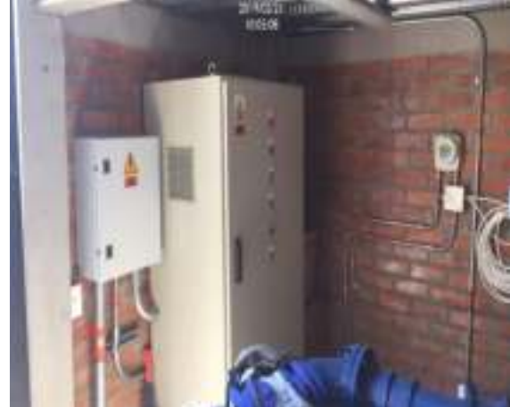
Accesorios, macromedidor, Valvulas de golpe de ariete y Gabinete eléctrico de la Estación de Bombeo del pozo La Victoria.
