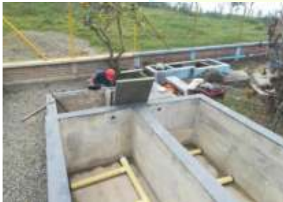
Recorrido estructuras PTAP San Isidro - El Chuzo - Filro Grueso
