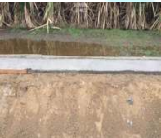
Fundición solado cerramiento perimetral
