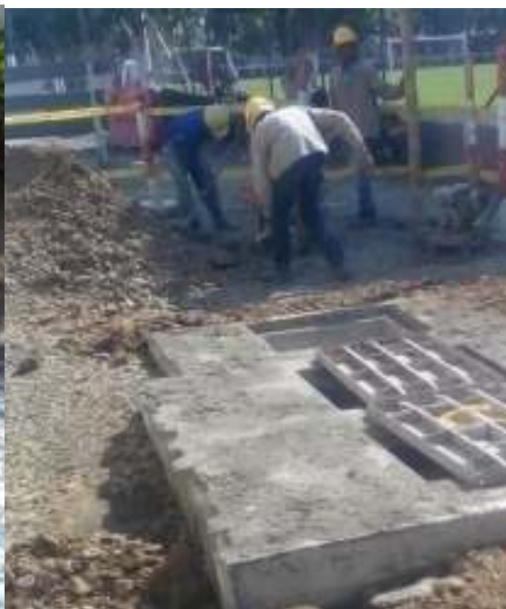
RELLENO AREA ANEXA A LA EBAR CONSTRUIDA.
