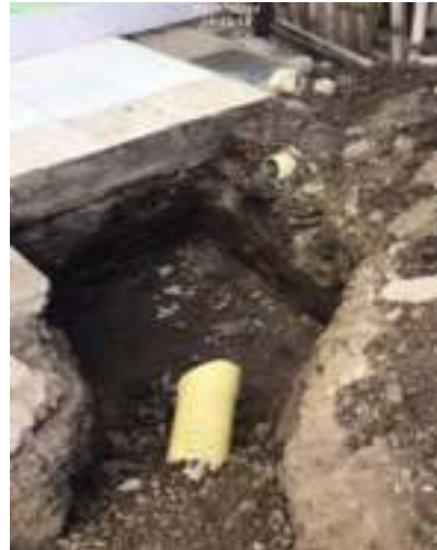
Construcción de pavimento
