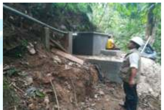
Recorrido estructuras PTAP San Isidro - El Chuzo - Desarenador
